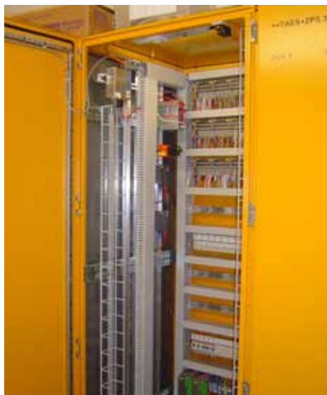
links In den Tunnelzentralen der Westumfahrung Zürich steuern Syslogic Rechner der Compact XS Serie (oberes Bildviertel) die Signale und Barrieren. (Bild: Moelbert AG)
