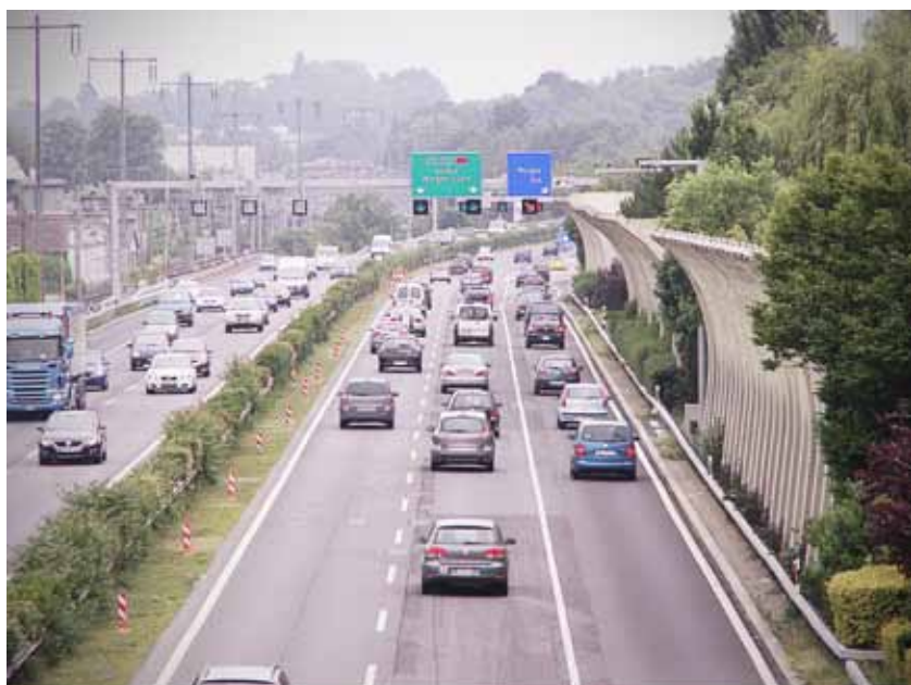
Zwischen Ecublens und Morges sorgt der Pannestreifen als zusätzliche Fahrspur für flüssigen Verkehr während der Stoßzeiten. Rechts zwischen den Lärmschutzwänden ist eine Unterstation sichtbar. (Bild RGR SA)
