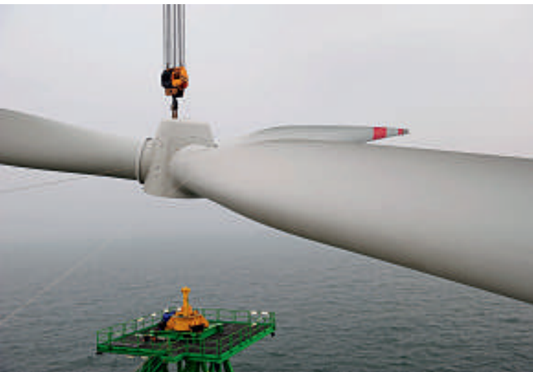
Montage eines mehr als 100 Tonnen schweren Rotorsterns
